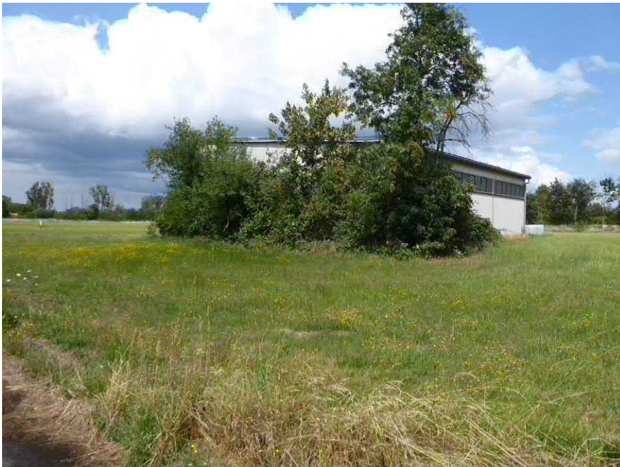
Abb. 8: Rechts von der Toranlage befindliches Gebäude der Bundeswehr
