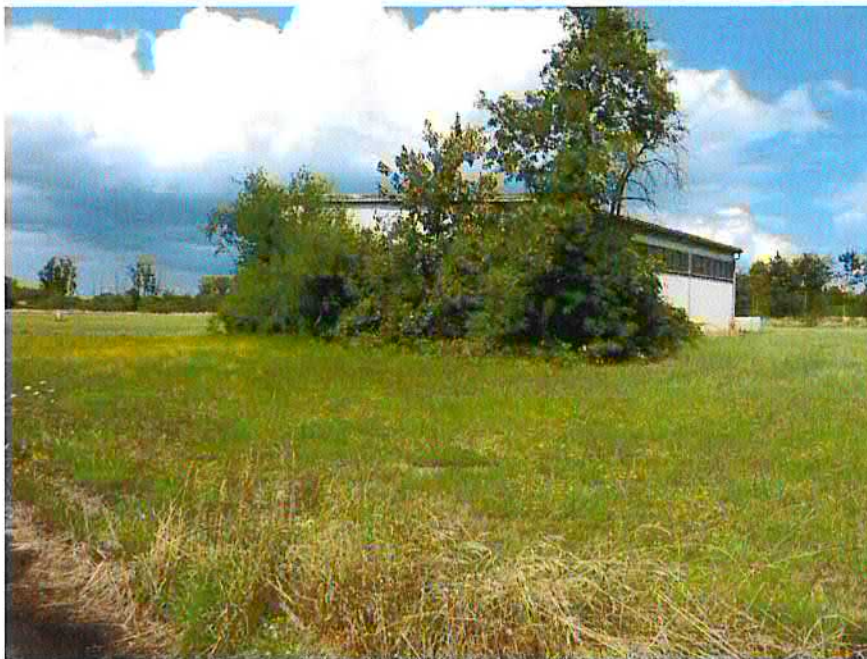
Abb. 6: Rechts von der Toranlage befindliches Gebäude der Bundeswehr
