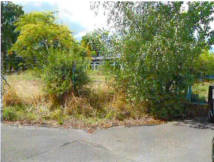
Abb. 5: Links von der Toranlage befindliches Gebäude (geplanter THW-Bereich)
