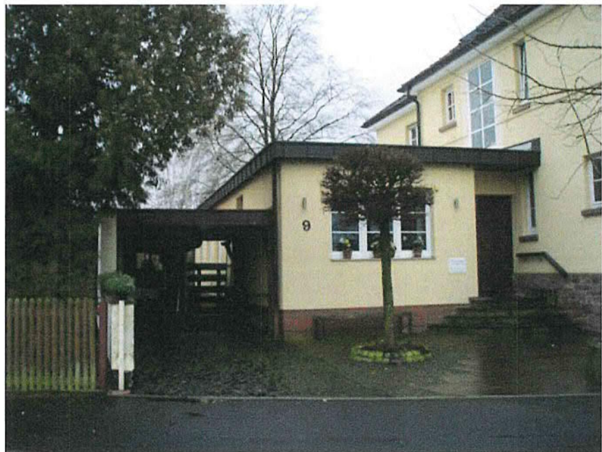
Abbildung 1: Wohnhaus, Praxisanbau und Carport an der Ostseite des Grundstückes
