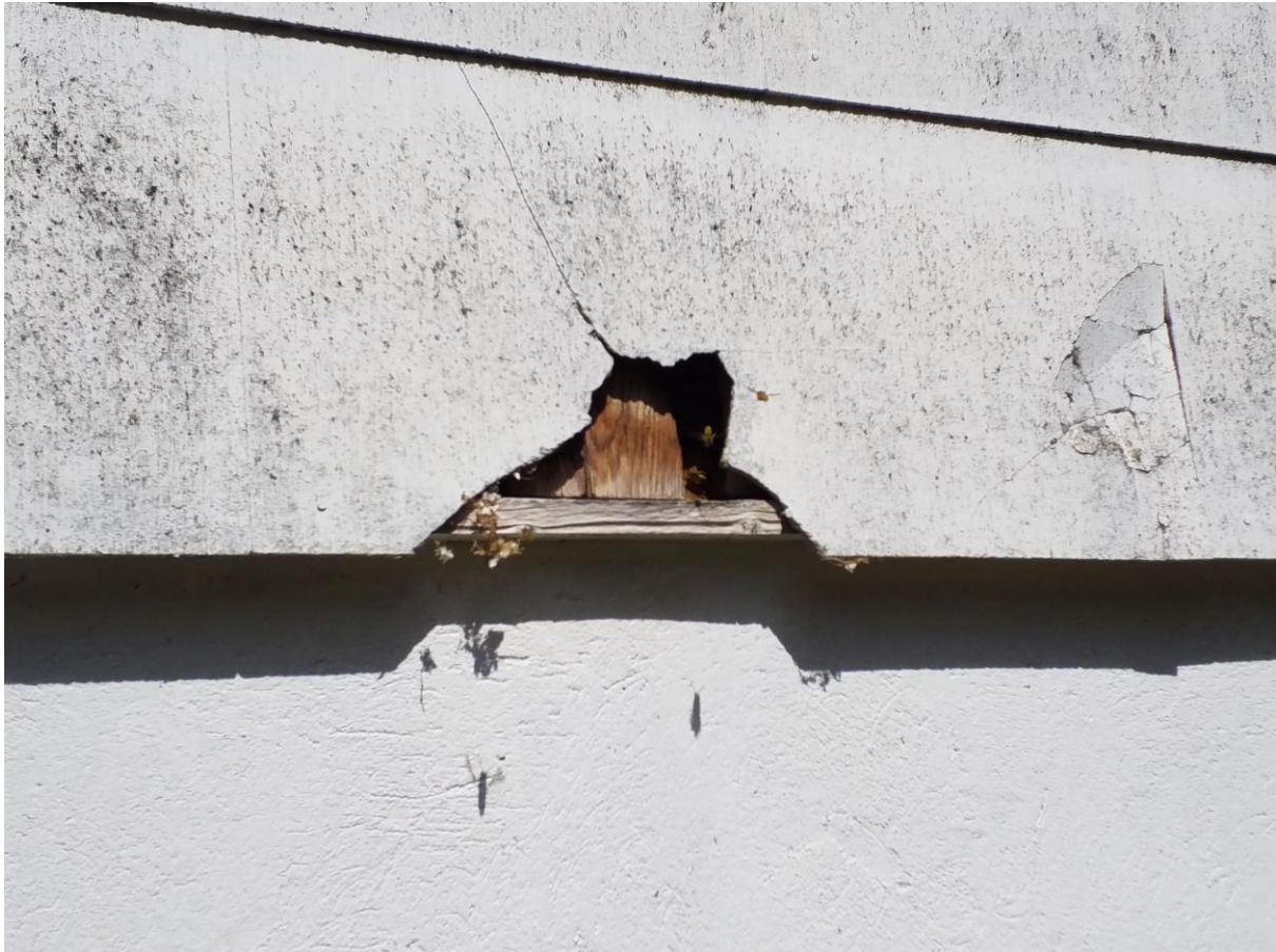
Abb. 7: Potenzielle Quartiermöglichkeit hinter verschindelter Fassade eines Gartenhäuschens (Wespennest im Jahr 2022)
